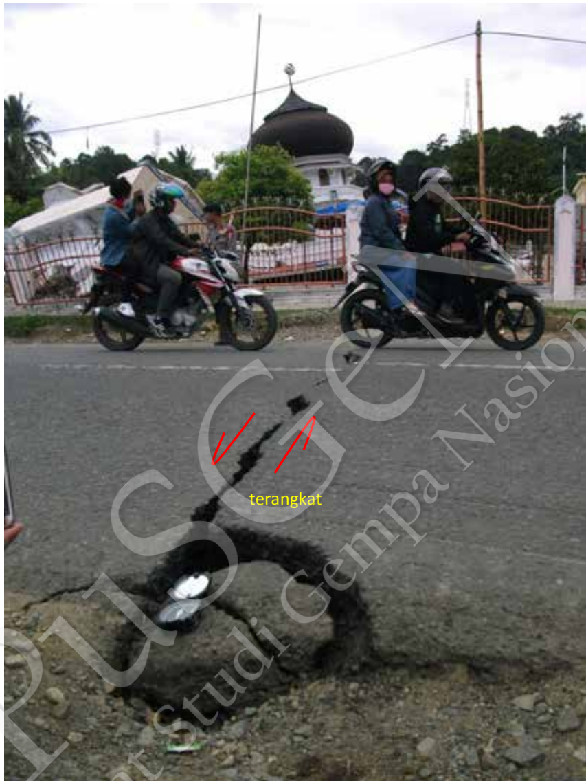
Gambar 32 Sesar permukaan di desa Kuta Pangwa mengakibatkan robohnya Masjid Jami Quba. Terlihat aspal bagian kanan agak terangkat. (Foto: Supartoyo, 2016)
