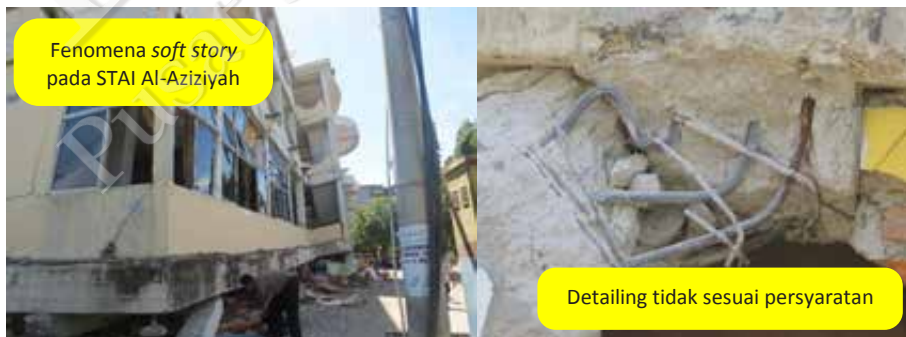
Gambar 91 Mekanisme keruntuhan soft story pada STAI Al-Aziziyah
