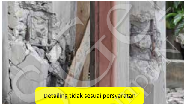
Gambar 95 Penulangan kolom tidak mengikuti persyaratan bangunan tahan gempa
