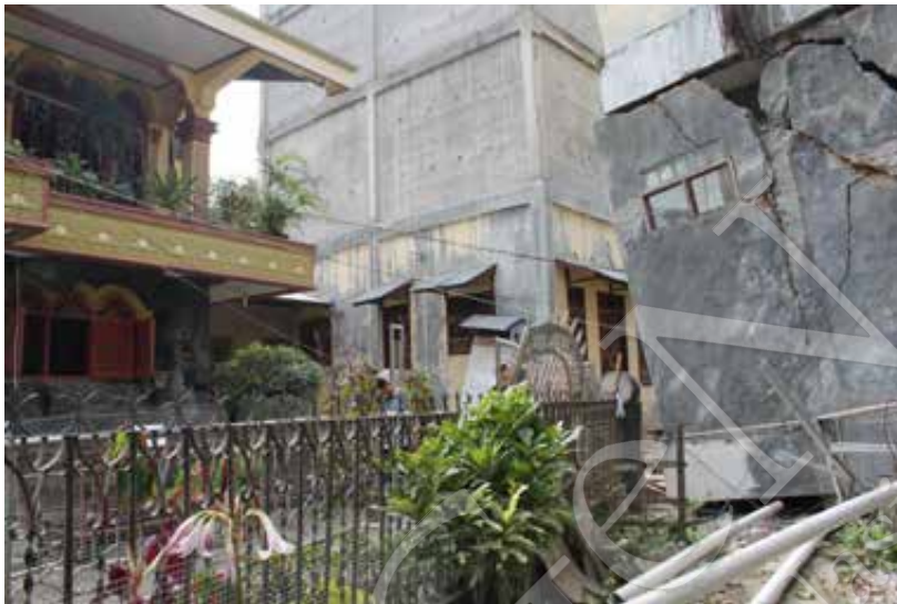
Gambar 104. Bangunan STAI Al Aziziah (sebelah kanan foto) roboh dengan lantai 1 hancur, sedangkan bangunan rumah (sebelah kiri foto) hanya mengalami rusak ringan
