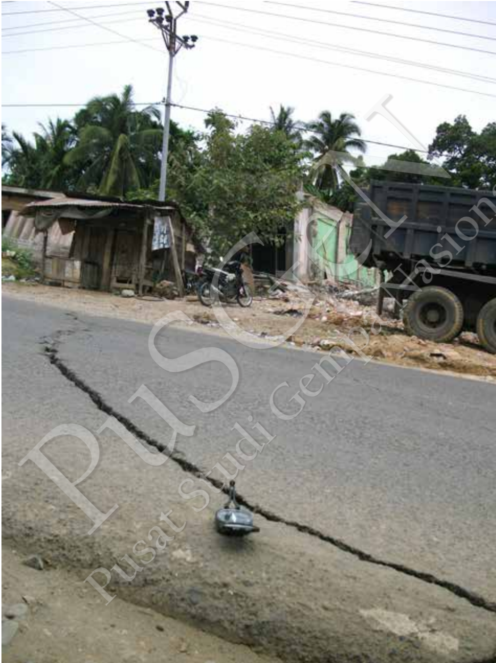
Gambar 36. Retakan menyerong relatif berarah U - S mengakibatkan robohnya ruko yang terletak di utara jalan (pada gambar di belakang dump truk). (Foto: Supartoyo, 2016)
