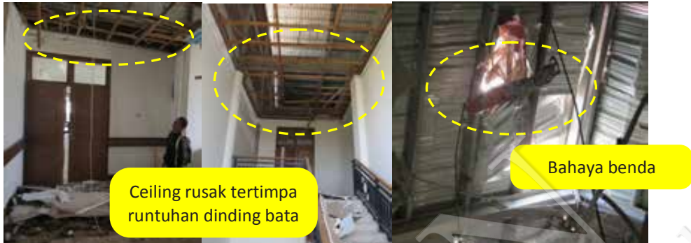
Gambar 88 Kerusakan nonstruktural (dinding bata) pada gedung-gedung perkantoran
