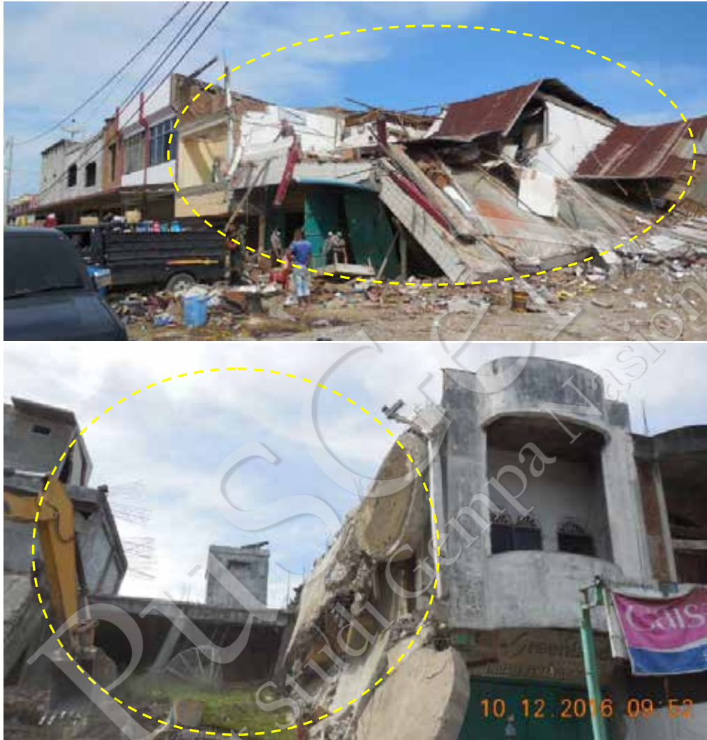
Gambar 96 Deretan ruko yang sebagian mengalami keruntuhan
