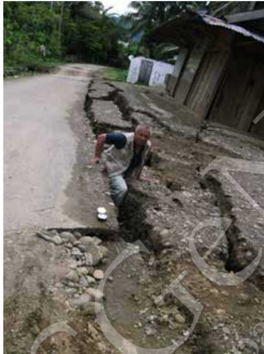
Gambar 83. Retakan tanah berarah utara-selatan mengakibatkan kerusakan jalan dan rumah penduduk di daerah Teumenah, akibat gempa tanggal 7 Desember 2016
