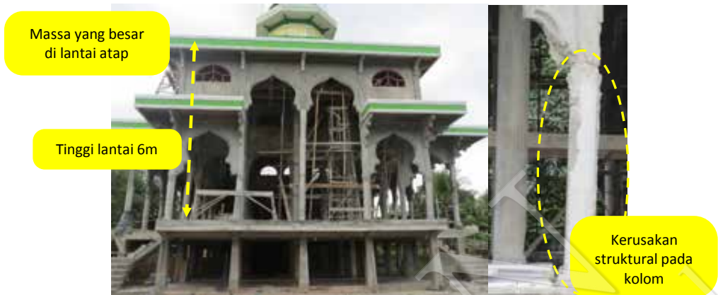
Gambar 94 Kerusakan struktur kolom pada Masjid Al-Qausas
