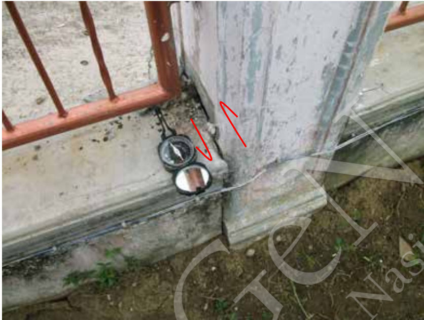
Gambar 33 Indikasi pergerakan mengiri dari tembok dan kolom yang berpindah. (Foto: Supartoyo, 2016)
