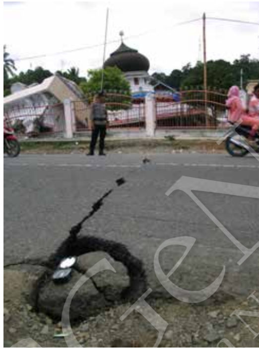
Gambar 81. Pergeseran tanah mengakibatkan robohnya Masjid Quba Jami, daerah Treanggadeng, akibat gempa tanggal 7 Desember 2016
