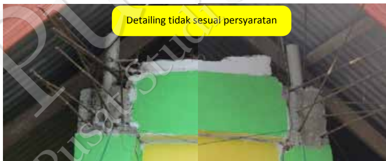
Gambar 93 Penulangan struktur kolom tidak mengikuti persyaratan bangunan tahan gempa
