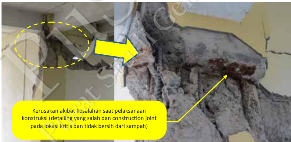
Gambar 89 Kerusakan struktural pada join balok-kolom di Gedung Kejaksaan Tinggi
