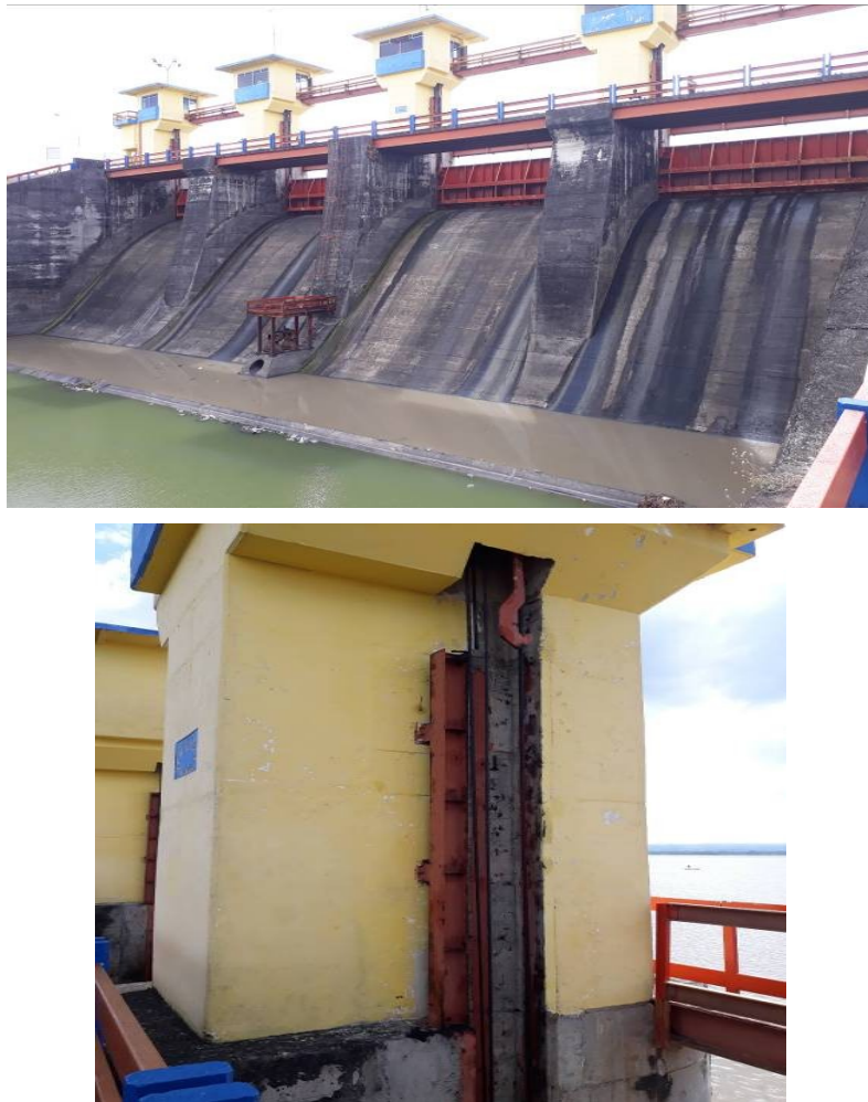
Gambar 15.32 Kondisi Bangunan Pelimpah (spillway) bendungan Batujai setelah diguncang gempa.
