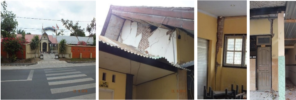
Gambar 12.5 Pemeriksaan bangunan gedung sekolah SDN 2 yang berlokasi di Gunung Sari yang memperlihatkan kerusakan pada bagian-bagian struktur dan non struktur berupa: retak geser-lentur pada dinding, plesteran dinding terkelupas, dinding terpisah/terlepas pada pertemuan dengan kolom akibat tidak dipasang anker, pada beberapa bagian ditemukan jatuhnya plafon. Secara keseluruhan bangunan ini dapat dikategorikan rusak sedang.
