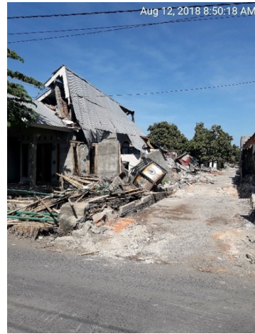
Gambar 16.1 Kerusakan pada bangunan non-engineered oleh gempa Lombok
