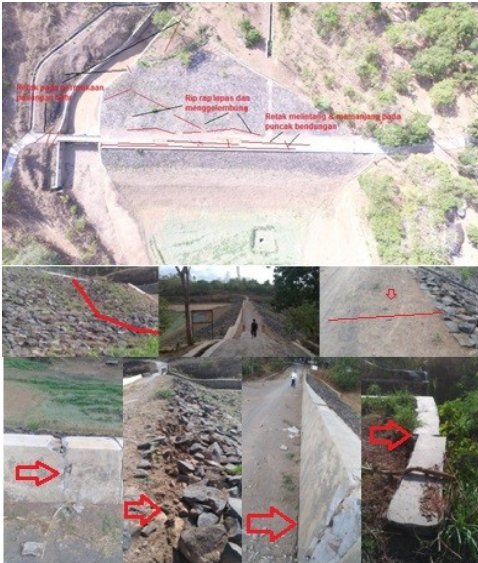
Gambar 15.3 Kerusakan pada puncak bendungan Gegurik
