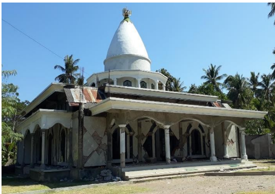
Gambar 17.1 Masjid Kerandangan dan ragam kerusakan pada kolom.
