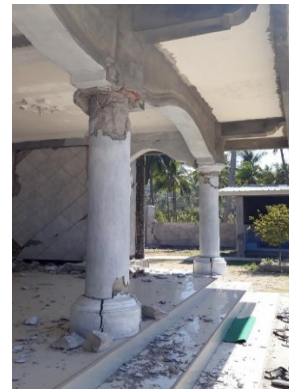
Gambar 17.1 Masjid Kerandangan dan ragam kerusakan pada kolom.
