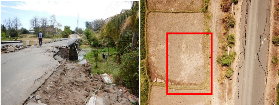
Gambar 6.3 (kiri) Pergerakan tanah pada tepi jembatan daerah Bayan, Lombok Utara dan (kanan) lateral spread yang diikuti oleh likuifaksi (kotak merah).
