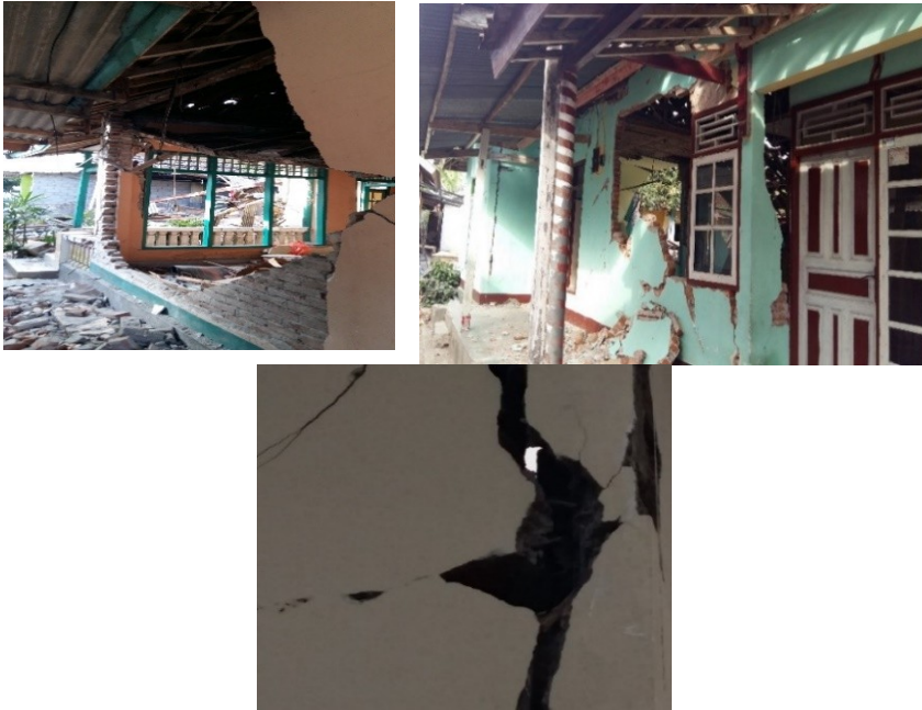
Gambar 12.3 Tipikal kerusakan bangunan rumah tinggal di daerah Lombok berupa runtuhannya pada dinding pasangan, hancurnya pada sambungan dinding – kolom dan runtuhnya pada rangka atap. Hampir seluruhnya diakibatkan kondisi bahan yang sudah tua (lapuk) atau bangunan tanpa rangka struktur kolom dan balok.
