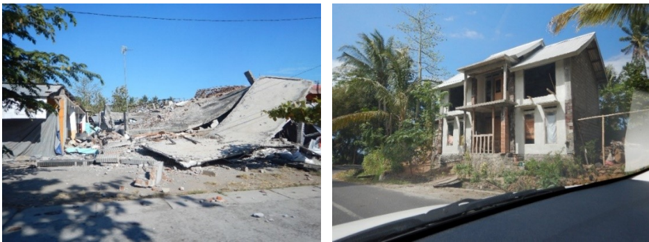
Gambar 6.6 Dampak gempa pada rumah penduduk yang dibangun di atas dataran alluvial (kiri) dan pada batuan breksi dan lava (kanan).
