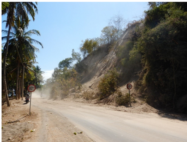
Gambar 6.2 Longsor pada tepi Jalan Raya Lombok Utara, Kecamatan Gangga. Debris berupa batuan tuff dari Formasi Lekopiko.
