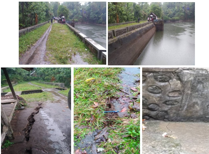
Gambar 15.23 Foto kerusakan pada puncak bendungan Jago.
