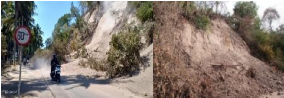
Gambar 10.8 Longsoran pada tebing antara Menangacangkring dan Kali Penggolong pada jalur Pemenang – Kayangan yang menghambat kelancaran lalu lintas dan membahayakan pengguna jalan karena longsoran masih aktif. Kanan, longsoran yang terjadi pada saat pemeriksaan. Kepulan asap berasal dari material yang bergerak turun ketika dirasakan gempa susulan (kiri). Longsoran pada tebing jalan antara Siduran dan Beraringan pada jalaur Jalan Pemenang-Kayangan (kanan).
