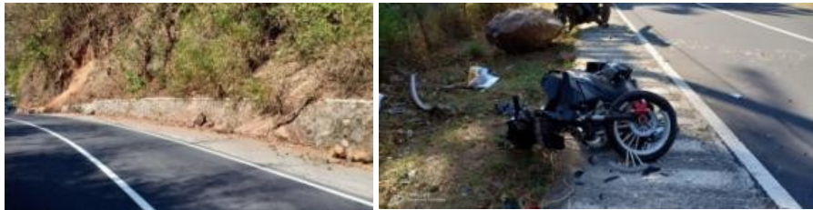
Gambar 10.5 Runtuhan batuan dan dinding tebing yang telah terkekarkan pada jalur jalan Mataram-Senggigi-Pemenang yang dapat membahayakan pengguna jalan (kiri). Sepeda motor mengalami kecelakaan akibat menabrak bongkah batu yang jatuh dari tebing (kanan).
