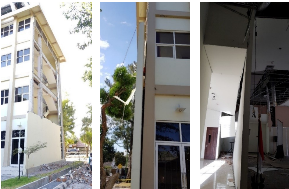
Gambar 16.2 Dinding tidak terikat dengan baik.
