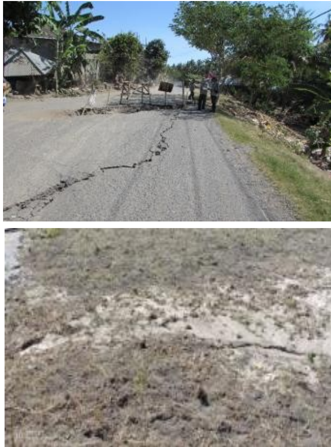
Gambar 10.7 Retakan dan nendatan di Lokok Piko, Dusun Jugil Barat pada badan jalan antara Pemenang – Kayangan (atas). Jejak likuifaksi yang dijumpai di sebelah barat retakan pada badan jalan (bawah).
