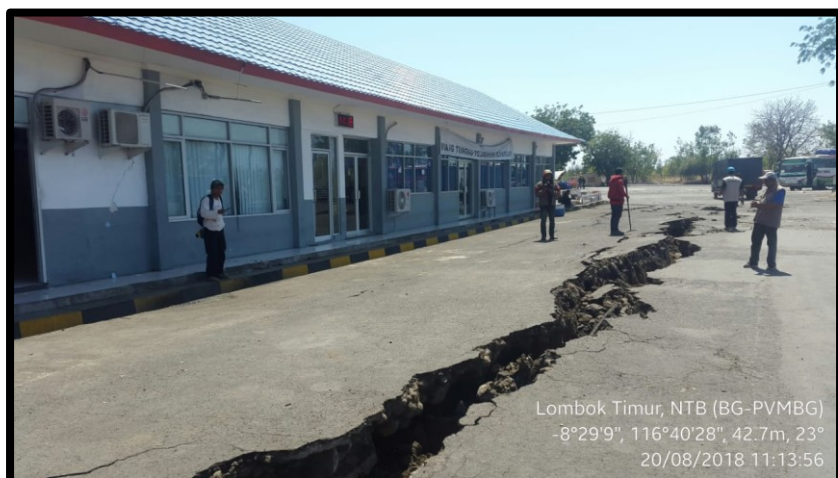
Gambar 9.4 Retakan tanah berarah N050°E mengakibatkan kerusakan jalan di Pelabuhan Kayangan, Desa Labuhan Lombok, akibat gempa 19 Agustus 2018.
