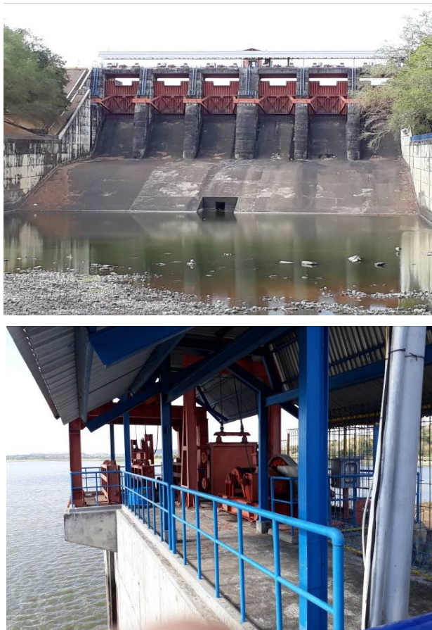
Gambar 15.31 Kondisi Bangunan Pelimpah (spillway) dan stop log bendungan Pengga setelah diguncang gempa
