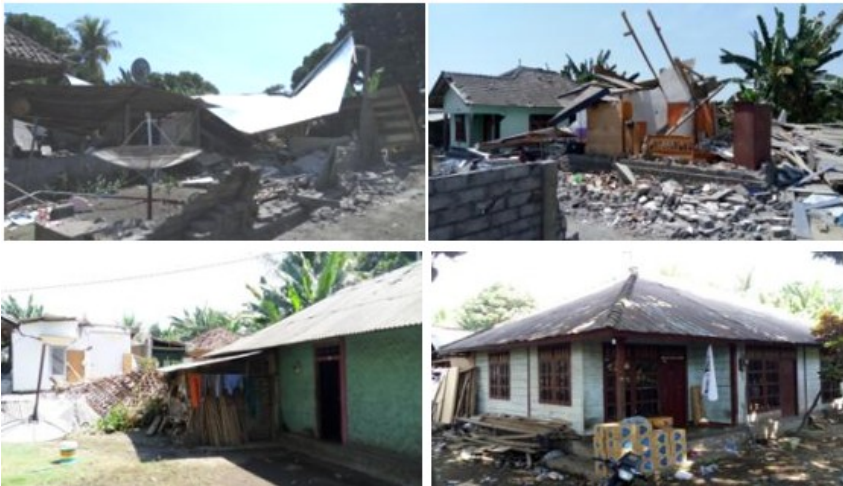
Gambar 7.6 Kerusakan bangunan di Dusun Ketapang, Desa Madayin, Kecamatan Sambelia akibat gempa tanggal 29 Juli 2018. Tidak terjadi kerusakan pada bangunan yang terbuat dari kayu dan bambu.
