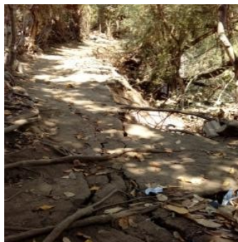
Gambar 7.7 Gerakan tanah pada jalan setapak di dekat pemukiman yang terjadi akibat guncangan gempa di Dusun Ketapang.
