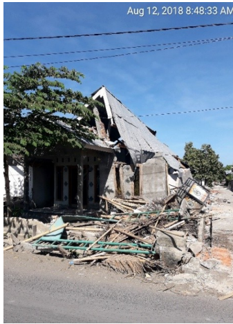
Gambar 16.1 Kerusakan pada bangunan non-engineered oleh gempa Lombok
