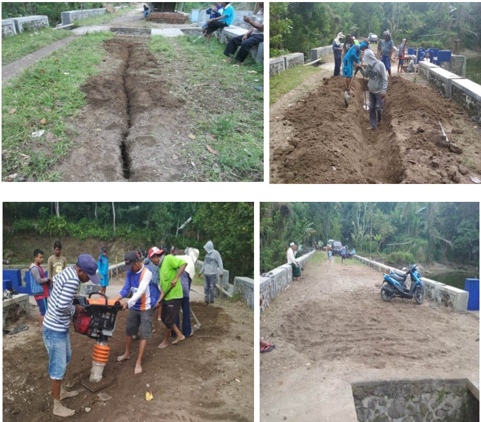
Gambar 15.25 Rehabilitasi puncak bendungan Jago.
