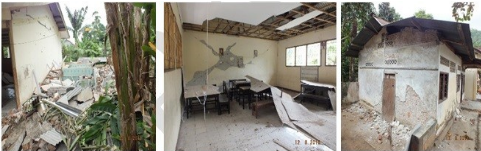
Gambar 12.6 Pemeriksaan bangunan gedung sekolah SDN 1 Lembah Sari yang berlokasi di Jalan Raya Mataram – Tanjung), Kel. Lembahsari, Kec. Batu Layar, yang memperlihatkan runtuhnya pada bangunan tambahan, kerusakan pada bagian-bagian struktur dan non struktur berupa: retak geser-lentur pada dinding, plesteran dinding terkelupas, Secara keseluruhan bangunan ini dapat dikategorikan rusak ringan – roboh.
