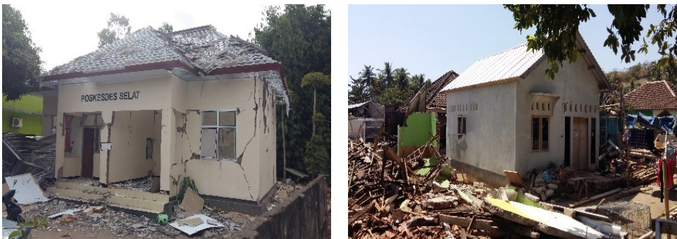
Gambar 12.4 Contoh kerusakan pada bangunan dengan rangka struktur yang masih berdiri walaupun sudah rusak berat (gambar kiri), sedangkan gambar kanan memperlihatkan bangunan dengan kondisi struktur yang baik tidak mengalami kerusakan dimana lingkungan sekitarnya mayoritas bangunan mengalami rusak berat – runtuh.
