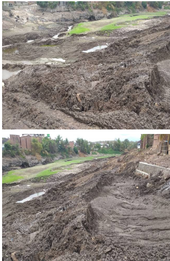
Gambar 15.22 Pengerukan lumpur dari dalam reservoir bendungan Tundak.
