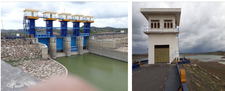
Gambar 15.30 Kondisi Bangunan Pelimpah (spillway) dan Bangunan Pengambilan bendungan Pandanduri.
