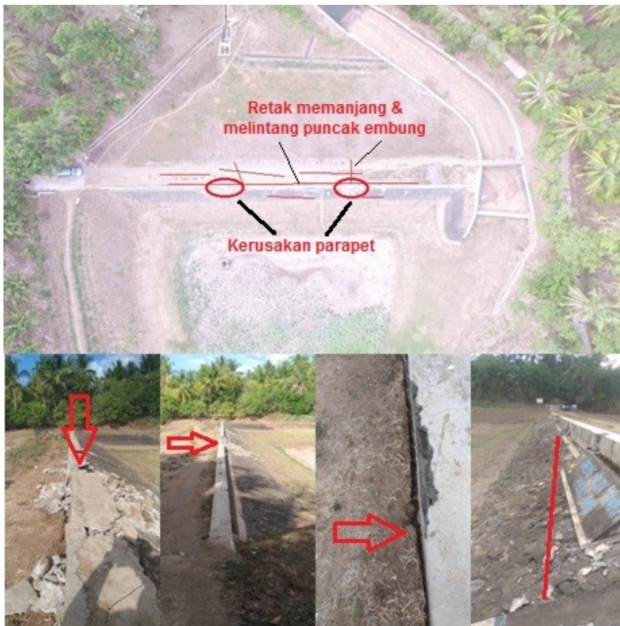
Gambar 15.5 Kerusakan pada puncak embung Lokok Tawah.
