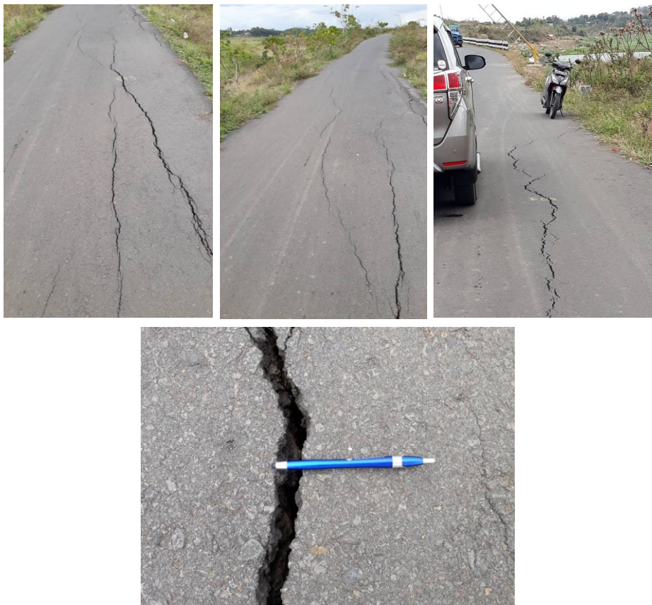
Gambar 15.18 Retakan pada jalan akses antara Saddle Dam 8 dan Saddle Dam 9 .
