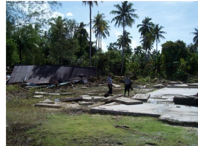
Atap dari sebuah gereja yang roboh dan terhanyut 10 meter dari pondasinya
