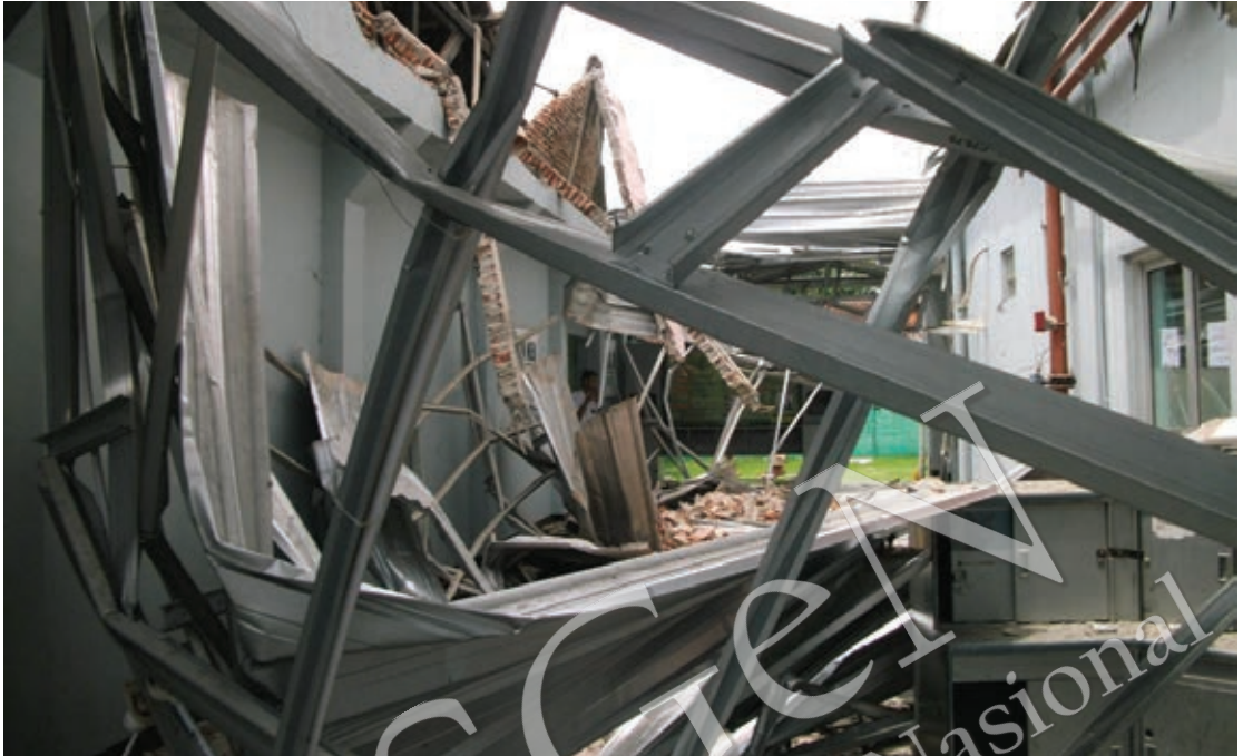
Gambar 5-25. Kerusakan pada ruang rontgen bagian luar di RSUD Banyumas akibat gempa bumi tanggal 15 Desember 2017.
