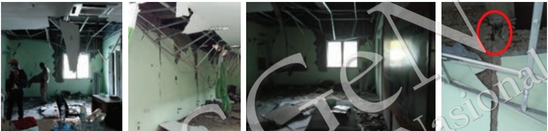
Gambar 6-12. Kerusakan plafon pada bangunan gedung Radiologi akibat runtuhnya rangka baja ringan. Gambar kanan adalah tulangan kolom praktis terekspos dan tidak tersambung dengan struktur utama.
