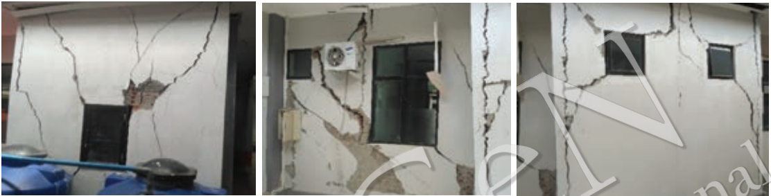
Gambar 6-7. Kerusakan pada dinding pasangan bata pada bagian luar gedung berupa plesteran terkelupas, retak geser dan lentur dalam jumlah yang cukup banyak.
