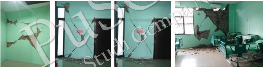
Gambar 6-8. Kerusakan pada dinding pasangan bata pada bagian dalam gedung berupa plesteran terkelupas, retak geser dan lentur dalam jumlah yang cukup banyak terutama terjadi pada lantai dasar.
