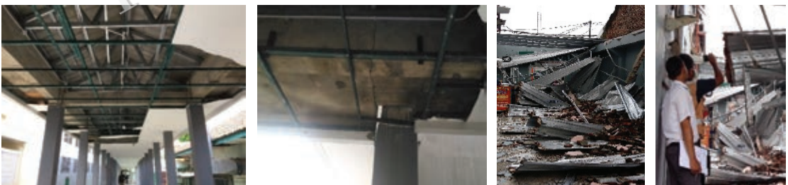
Gambar 6-9. Kerusakan plafon pada selasar penghubung dan pada bangunan gedung Talasemia. Gambar kanan adalah runtuhnya rangka atap baja ringan pada bagian penghubung dengan gedung Radiologi.
