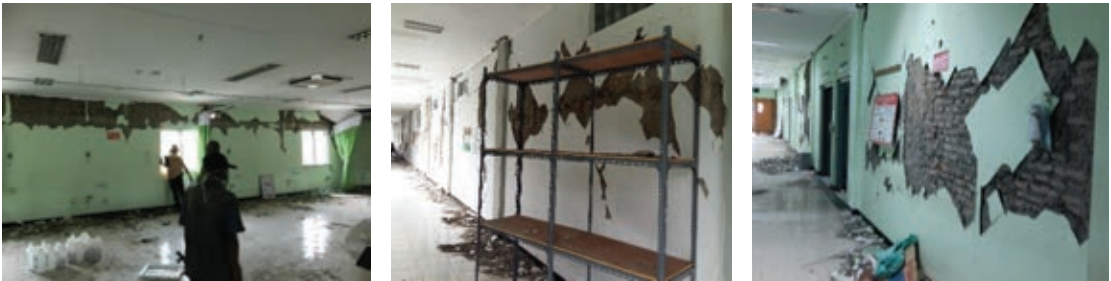
Gambar 6-11. Kerusakan dinding pada lantai dasar, 1, dan 2 gedung Radiologi berupa plesteran terkelupas, retak geser pada sebagian besar dinding, dan hancuran pada beberapa tempat.
