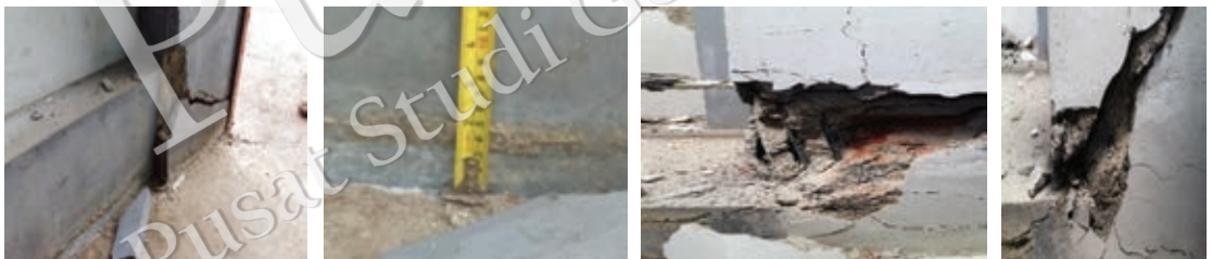
Gambar 6-6. Beberapa indikasi penurunan tanah tampak pada bagian luar gedung Talasemia ditemukan pada beberapa tempat yang menyebabkan kerusakan pada struktur kolom praktis. Pada gambar tengah penurunan teras beton bagian luar mencapai sekitar 4.5 cm.
