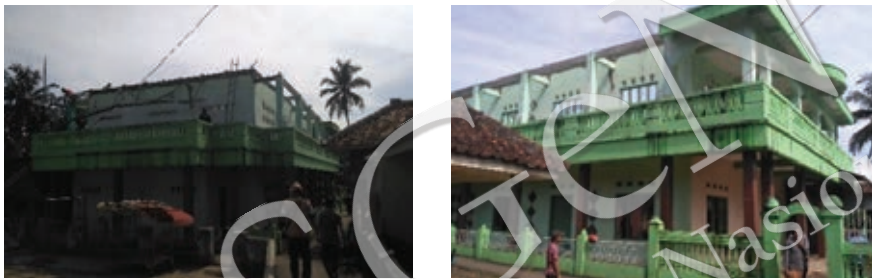
Gambar 6-2. Kerusakan pada bangunan Mesjid Asy-Syuhada yang terbuat dengan struktur rangka beton bertulang dengan dinding pengisi rusak ringan berupa plesteran terkelupas pada beberapa titik. Struktur atap dengan rangka baja ringan dan penutup atap genteng mengalami kerusakan kemungkinan akibat kualitas rangka baja ringan kurang baik (ketebalan \leq 0.75 mm dengan bentang > 6 m, jarak antar kuda2 terlalu lebar \geq 1 m sehingga terlalu berat menahan beban.
