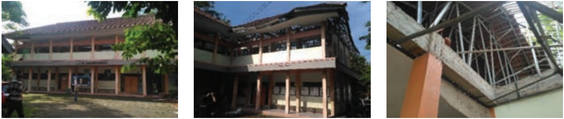
Gambar 6-1. Kerusakan pada bangunan gedung SMKN 3 TASIKMALAYA Jl. Tamansari No.100, Mulyasari, Tasikmalaya. Struktur utama berupa sistem rangka beton bertulang tidak ada kerusakan. Pada Bagian pojok L pendek struktur atap runtuh. Kemungkinan penyebab kerusakan adalah kualitas struktur baja ringan yang rendah terutama konstruksi di area L (bagian pojok) dimana jarak antar kuda2 terlalu lebar \geq 1 m dengan ketebalan rangka baja mungkin kurang dari \leq 0.75 mm dan beban genteng tanah liat terlalu berat.
